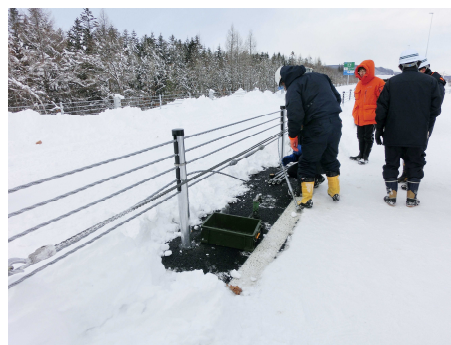
写真 22 ワイヤロープを切断
