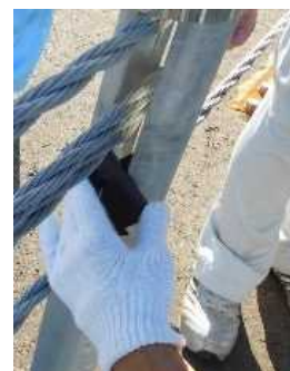
写真 34 回転式間隔材取付方法
