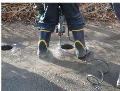
写真 11 ドリルで4 か所を穿孔
