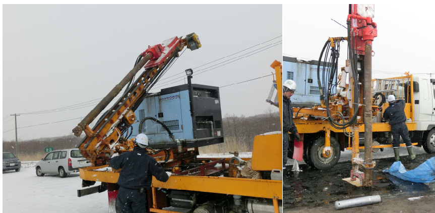
写真 16 岩削機（支柱打ち込みを併用する施工機械）
