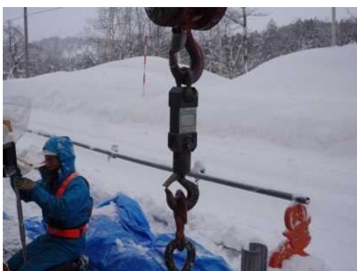
写真 19 20kN の張力を掛けながら牽引
