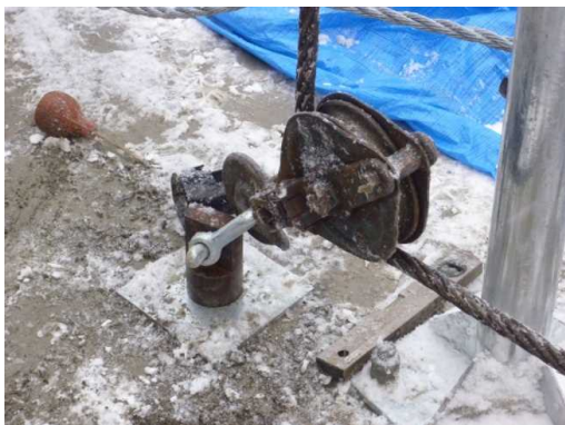
写真 17 端末基礎に穿孔後、アンカー取り付け
