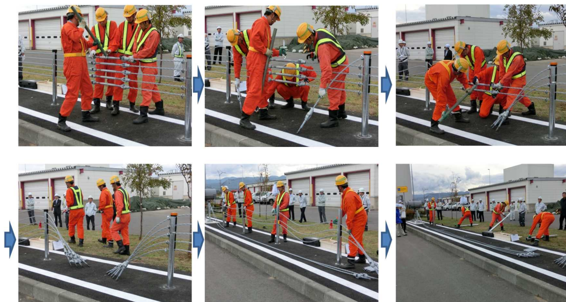
写真 3 緊急時の支柱取り外し及び開口部の設置方法
