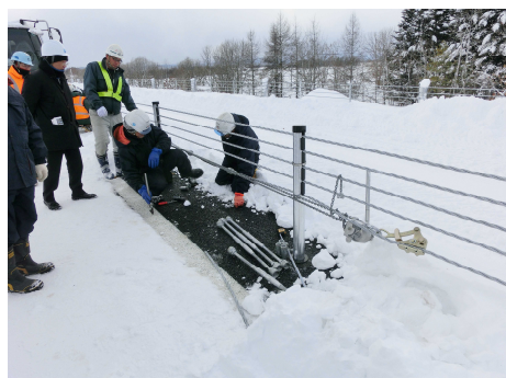
写真 21 レバブロックの取り付け
