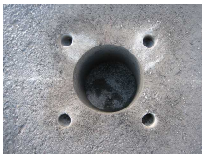
写真 12 削孔状況
