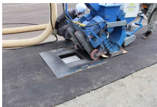
写真 24 鉄製型枠を使用したブラスト工法
