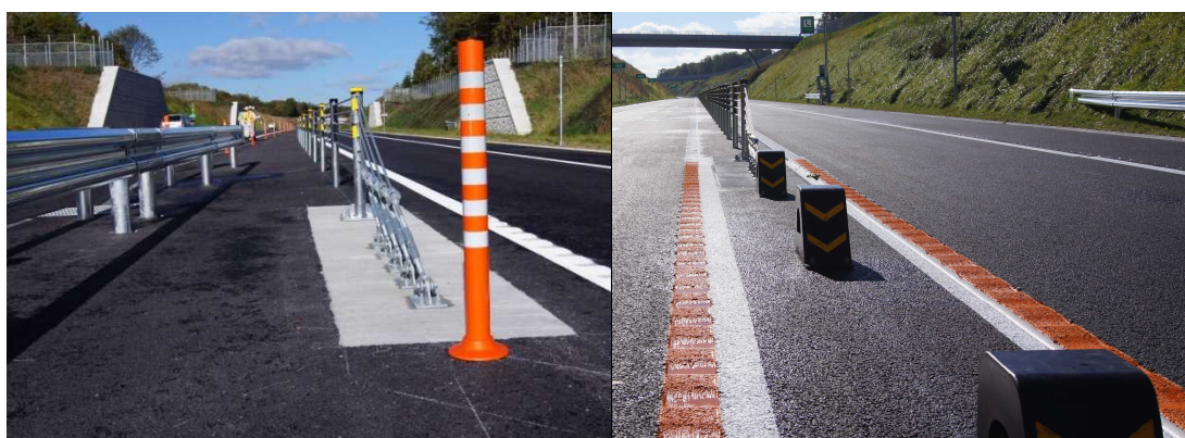
写真 6 道央自動車道の事例
