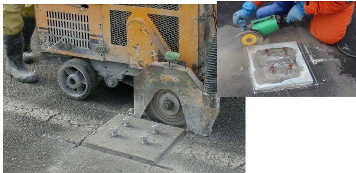
写真 27 目地カッターやハンドカッターによる目地の施工 ※基礎コンクリート側面を平らに切削する。
