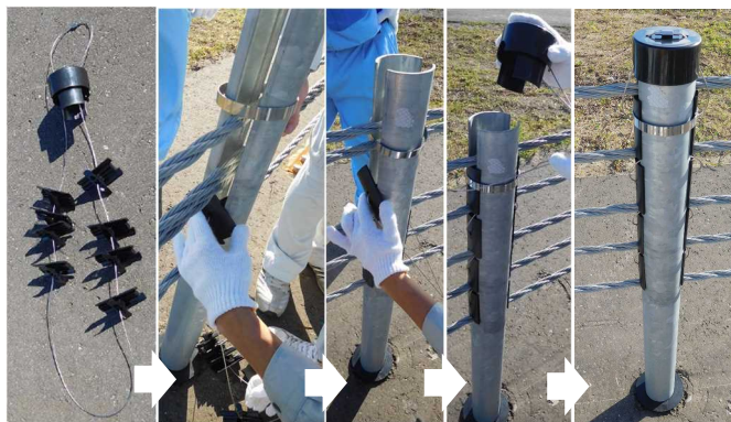
写真 31 孔あき樹脂キャップ、回転式間隔材、飛散防止ワイヤ
