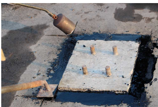
写真 26 高機能防水システムの防水材施工（グースアスファルト系路面補修材）
