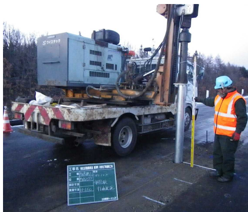
写真 10 打ち込みアタッチメント使用状況
