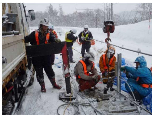
写真 18 クレーンでワイヤロープを緊張
