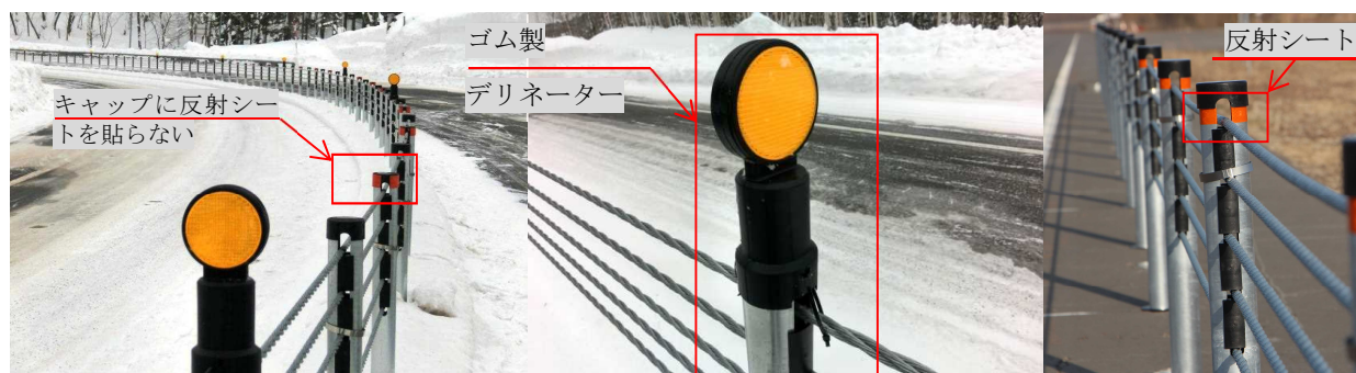
写真 8 ゴム製デリネーターと反射シートの設置状況（一般国道 275 号音威子府村）とキャップ下の支柱に反射シートを貼付した状況
