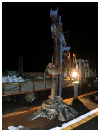
写真 9 岩削機による削孔状況
