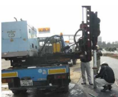
写真 14 支柱打込み機械
