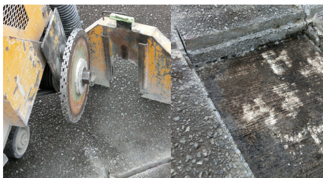
写真 23 目地カッターで防水材施工溝を事前に施工
