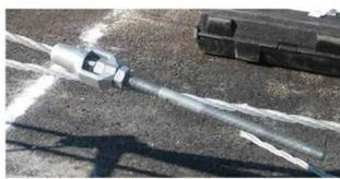
11-4.両側のねじ棒にターンバックルをねじ込む
