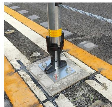
写真 36 橋梁用支柱基部保護材
