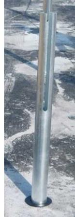
6.ワイヤロープを端末支柱用間隔材に通し、
