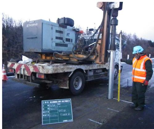
写真 13 打ち込みアタッチメント使用状況
