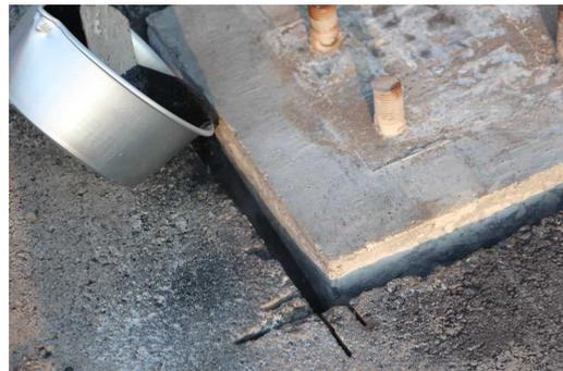
写真 34 高性能防水システム以外の防止材施工（加熱施工式注入目地材）
