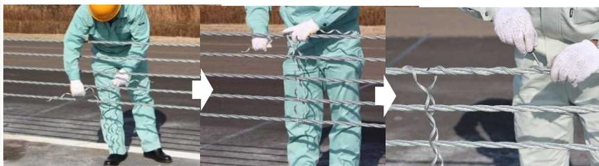
写真 27 ロープ連結材の取り付け方法
