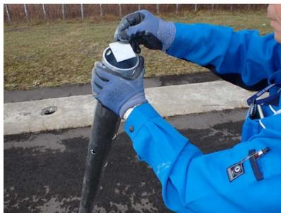
写真 47 支柱底穴防水処理
