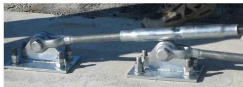
9.ワイヤロープを設置し間隔材とストラップを取り付ける。(ストラップは、ケーブルの4段目の上に取付ける)
