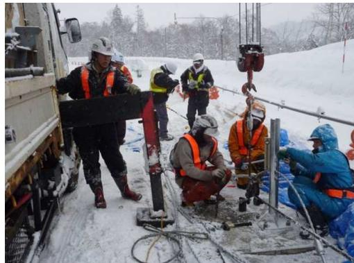
写真 21 クレーンでワイヤロープを緊張
