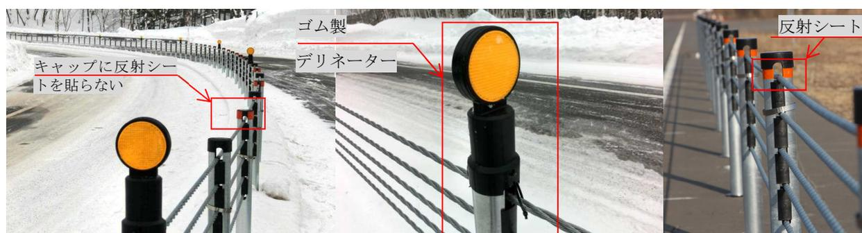
写真 10 ゴム製デリネーターと反射シートの設置状況
