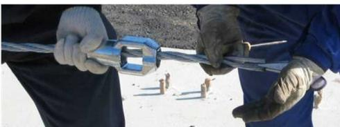
8.索端金具にねじ棒、ターンバックル、ジョーボルトを
