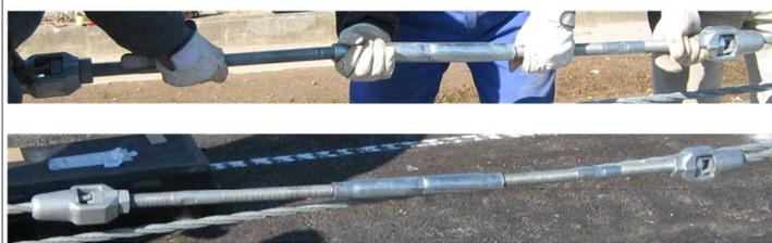
11-5.両端末の施工終了後、両側のねじ棒を固定し、ターンバックルをねじ込み張力を調整する
