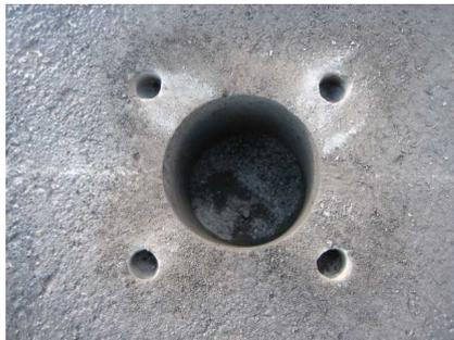
写真 15 削孔状況
