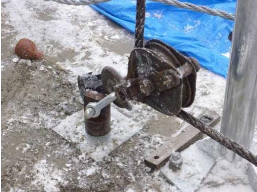
写真 20 端末基礎に穿孔後、アンカー取り付け
