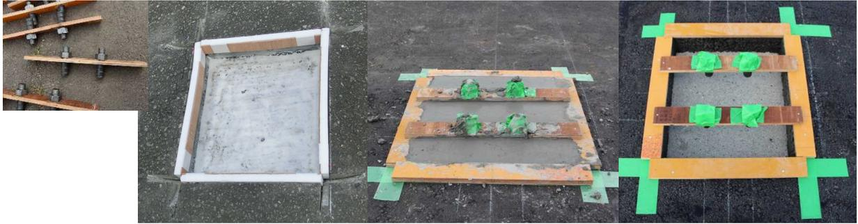
写真 30 型枠設置とコンクリート打設（高機能防水システム以外）
