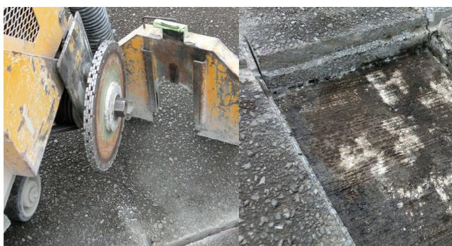
写真 28 目地カッターで防水材施工溝を事前に施工
