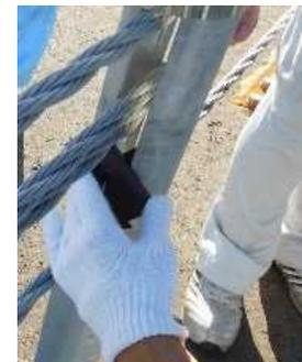
写真 56 回転式間隔材取付方法
