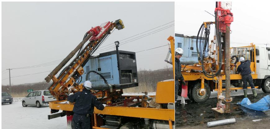
写真 19 岩削機 (支柱打ち込みを併用する施工機械)
