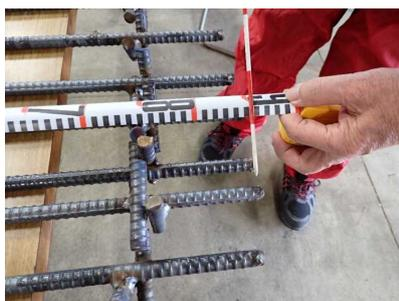
写真 46 鉄筋の巾止め加工
