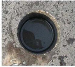
2.エアーストライカーによりスリーブを打ち込む
