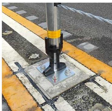
写真 45 橋梁用支柱基部保護材
