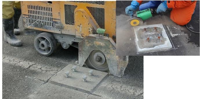
写真 32 目地カッターやハンドカッターによる目地の施工
