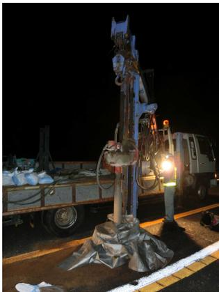
写真 12 岩削機による削孔状況
