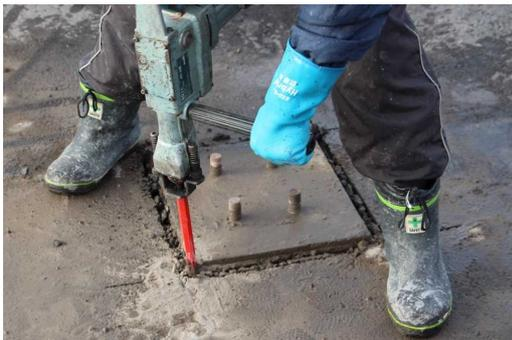
写真 33 目地部分のアスファルト撤去
