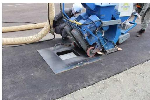
写真 29 鉄製型枠を使用したブラスト工法
