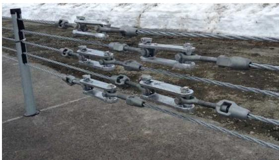
写真 4 緊急開放金具設置状況
