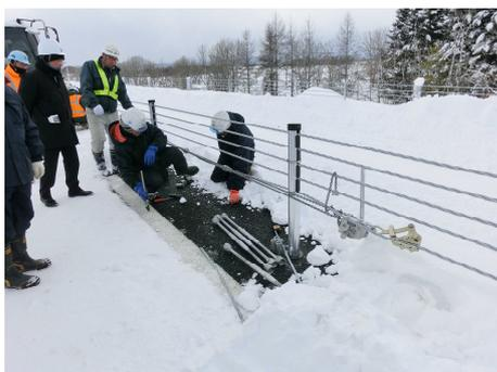
写真 24 レバーブロックの取り付け
