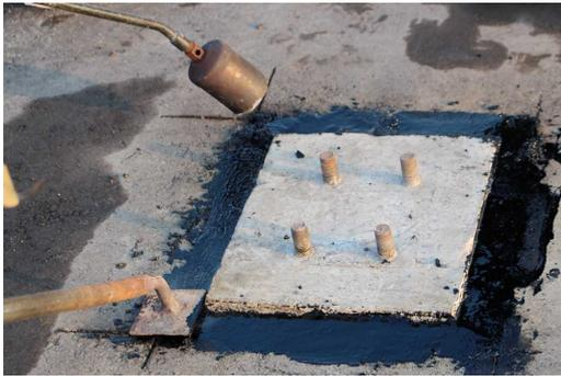
写真 31 高性能防水システムの防水材施工（グースアスファルト系路面補修材）
