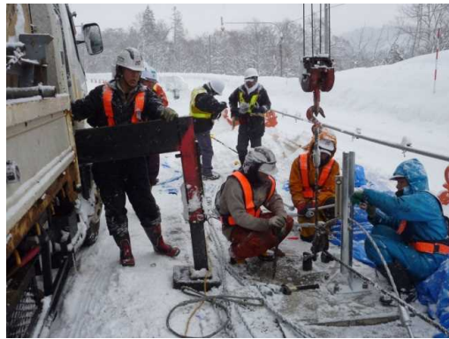
写真 20 クレーンでワイヤロープを緊張
