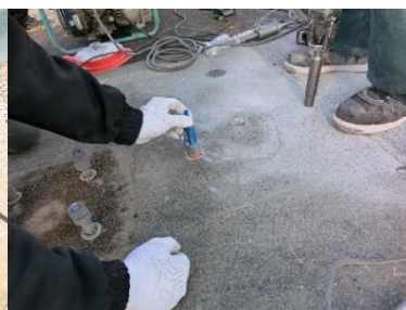
写真 37 アンカー打込み
