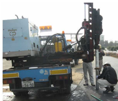
2.エアーストライカーによりスリーブを打ち込む
