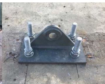
写真 38 端末金具固定 (突出しすぎたねじ山は切断)
