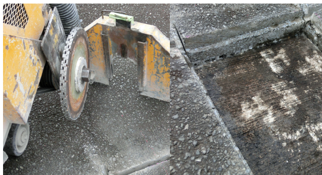
写真 27 目地カッターで防水材施工溝を事前に施工
