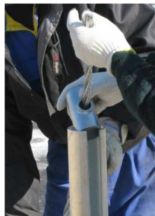
6.ワイヤロープを端末支柱用間隔材に通し、 端末支柱に落とし込む
