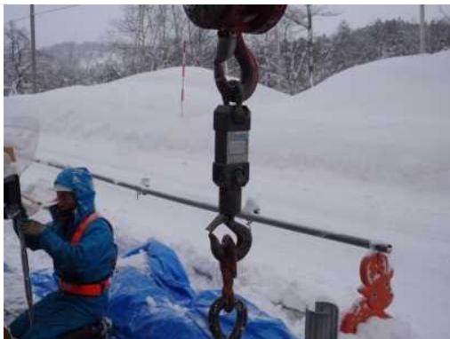
写真 21 20kN の張力を掛けながら牽引
