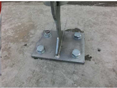
写真 41 中間支柱固定
