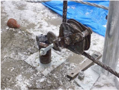
写真 19 端末基礎に穿孔後、アンカー取り付け
