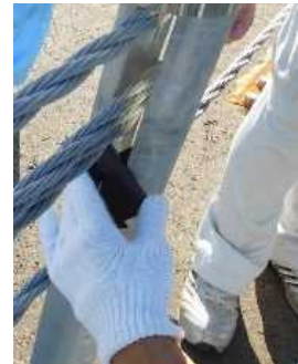
写真 44 回転式間隔材取付方法
