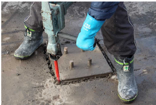
写真 28 目地部分のアスファルト撤去 ※基礎コンクリートに振動を与えないように注意する。
