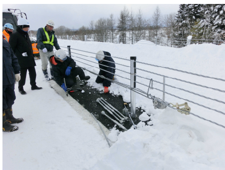
写真 23 レバブロックの取り付け
