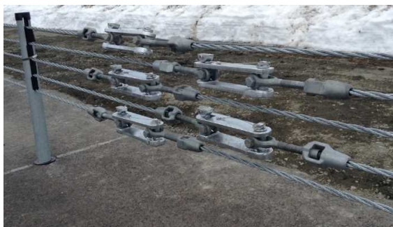
写真 4 緊急開放金具設置状況
