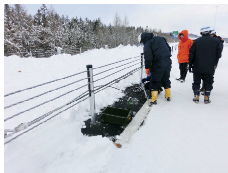
写真 24 ワイヤロープを切断
