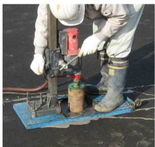
1.アスファルトをコア抜きする
