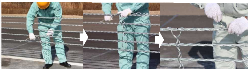
写真 26 ロープ連結材の取り付け方法
