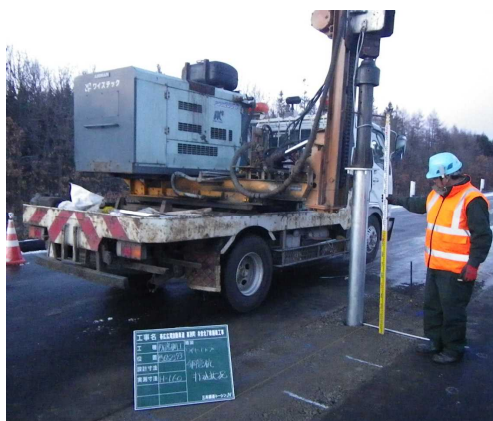
写真 12 打ち込みアタッチメント使用状況
