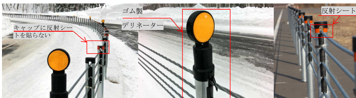
写真 9 ゴム製デリネーターと反射シートの設置状況 (一般国道 275 号音威子府村) とキャップ下の支柱に反射シートを貼付した状況
