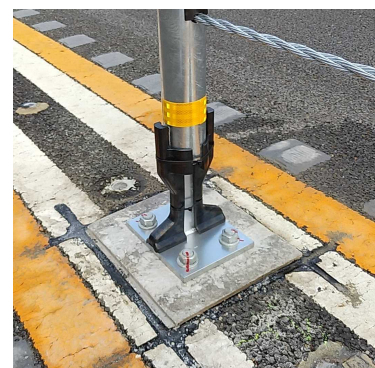
写真 33 橋梁用支柱基部保護材
