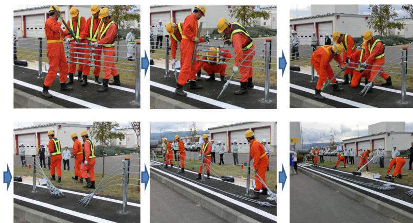
写真 3 緊急時の支柱取り外し及び開口部の設置方法
