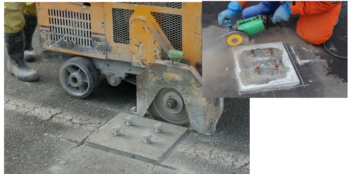
写真 30 目地カッターやハンドカッターによる目地の施工 ※基礎コンクリート側面を平らに切削する。
