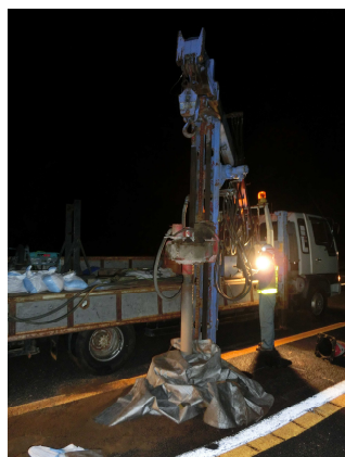
写真 11 岩削機による削孔状況
