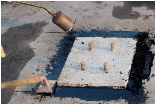
写真 31 高機能防水システムの防水材施工（グースアスファルト系路面補修材）
