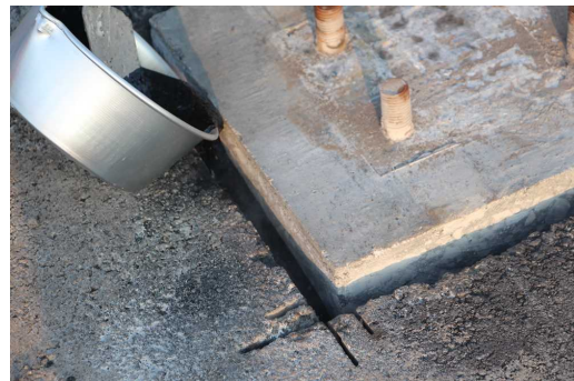
写真 29 高機能防水システム以外の防止材施工（加熱施工式注入目地材）
