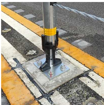
写真 42 橋梁用支柱基部保護材
