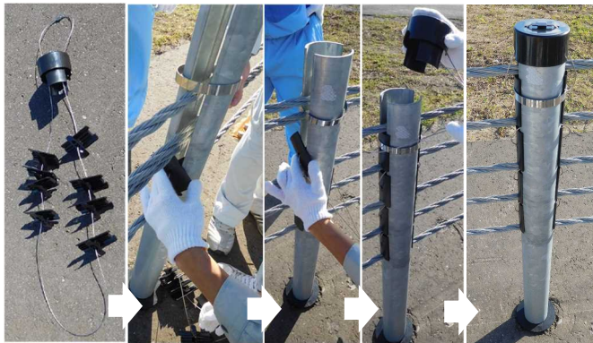
写真 34 孔あき樹脂キャップ、回転式間隔材、飛散防止ワイヤ 写真 35 車両衝突実験後の状況
