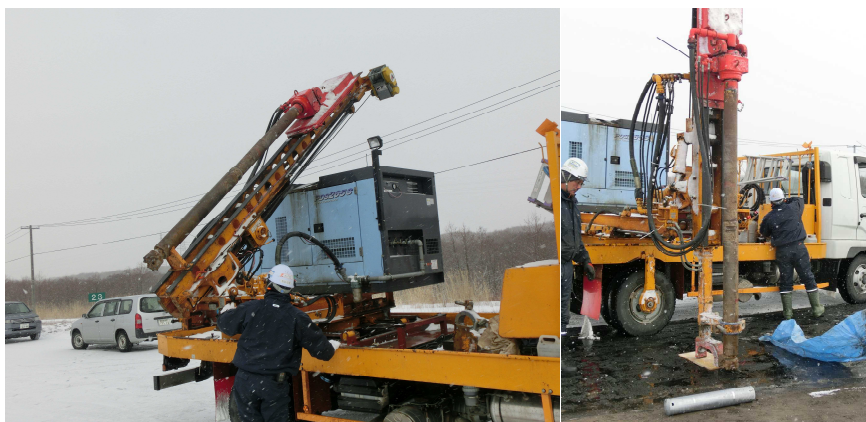
写真 18 岩削機（支柱打ち込みを併用する施工機械）
