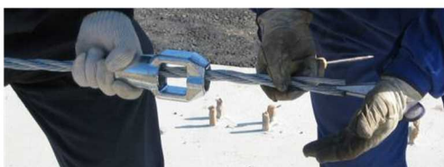
7.索端金具を取り付ける
