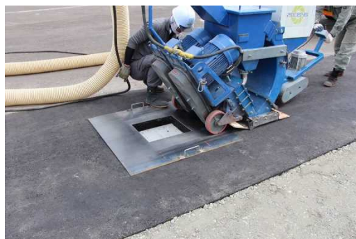
写真 28 鉄製型枠を使用したブラスト工法
