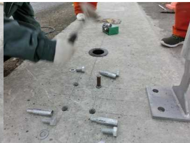
写真 40 アンカー打込み
