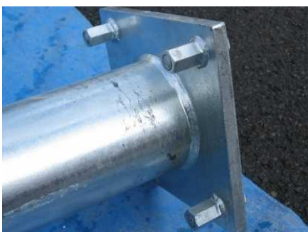
写真 15 ボルト取り付け状況
