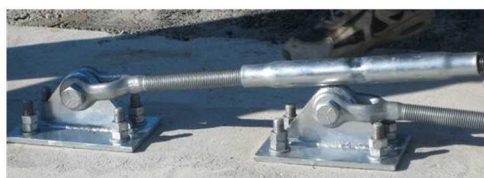
8.索端金具にねじ棒、ターンバックル、ジョーボルトを ねじ込み、端末金具にボルト固定する
