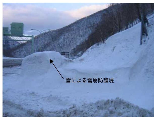
写真 4.2-1 雪による雪崩防護堤の構 例
