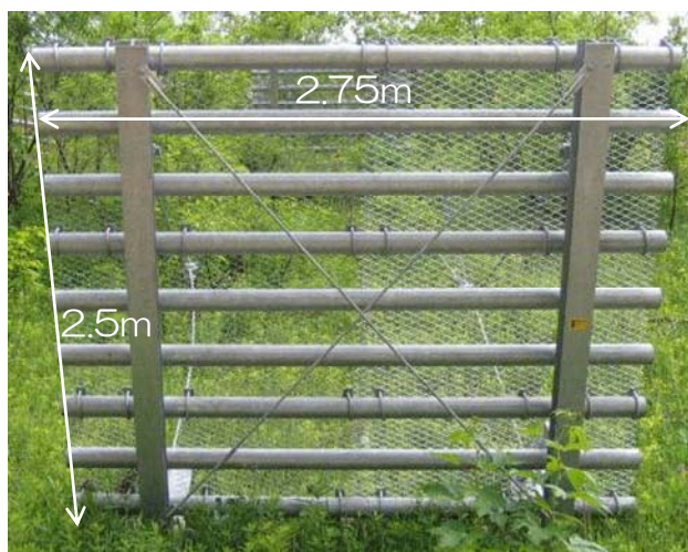
写真 3.2-1 ネット工による支持面材への対策例 エキスパンドメタル(XS62)を取り付けた例
