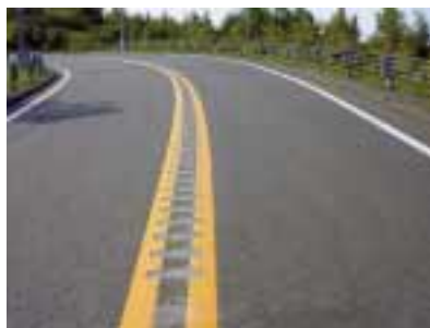
写真 2-2. 急カーブ区間における暫定的なランブルストリップスの設置状況
