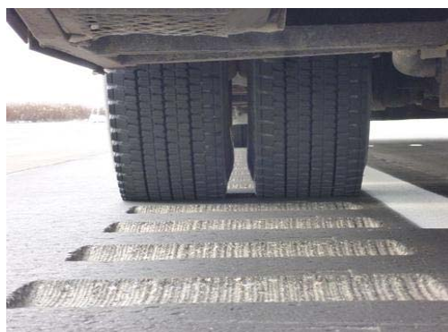
写真6-2. 切削溝横幅の例
