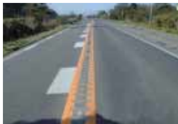
写真5-20. ランブルストリップスの設置
