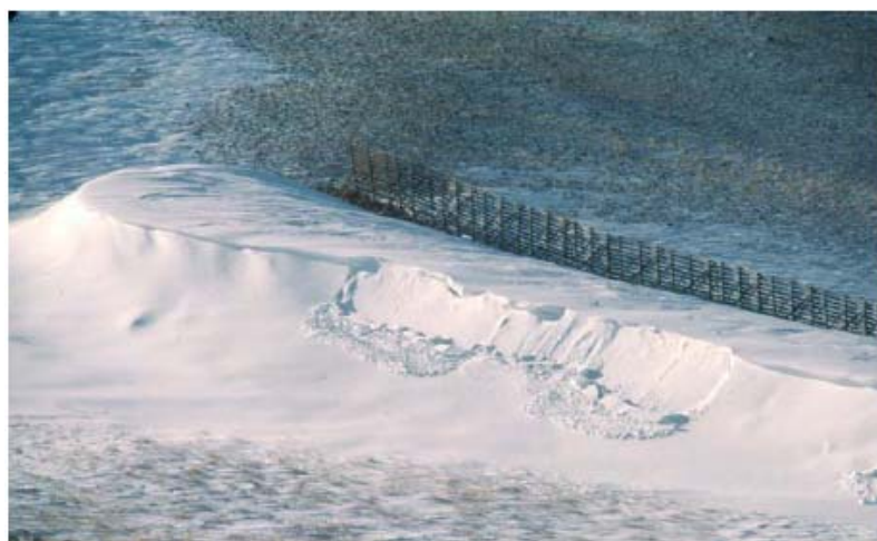
図 3.32 3.8m 高さの防雪柵の後方にあるスリップ・フェースと雪 (Tabler1994)。雪丘の深さは雪 位置で約 3.7m。
