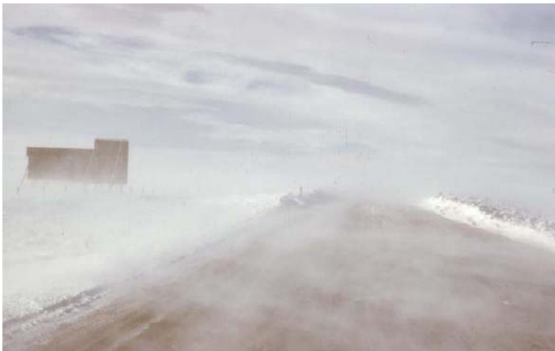
図 4.5 路側より 30m 離れたところにある広告板が吹きだまりを生じている (Tabler 1994)。なお、除雪作業者はこの原因には気づいてはいなかった。
