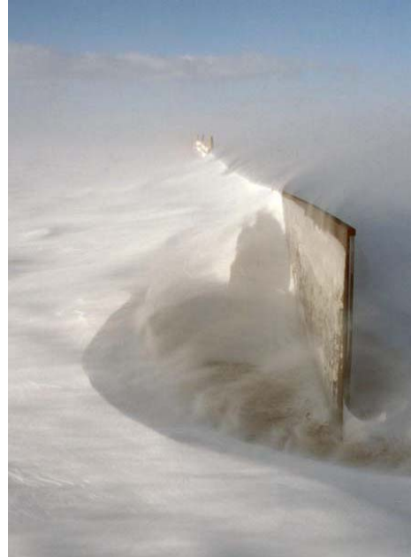
図 3.60 高さ 1.2m の空隙の無い柵の先端で射される雪粒子は風上の吹きだまりが空隙の無い柵先端に達した後なぜ捕捉率が低下する理由を示している。(Tabler 1994)
