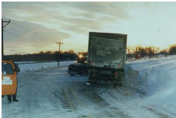
図 2.1 この致命的な事故は、カーブの吹きだまりによる見通し距離の低下が原因である可能性がある。
