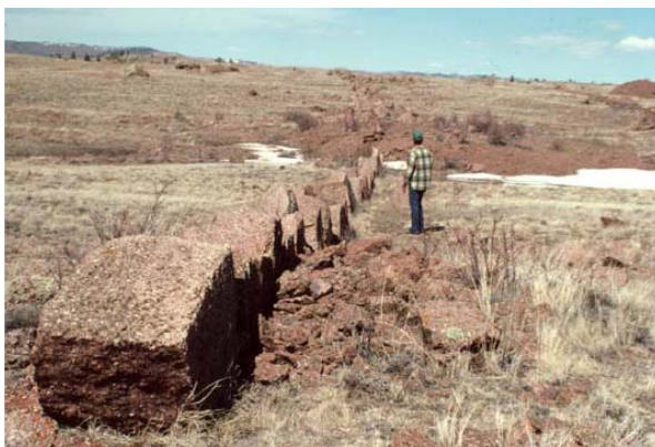
図 2.3 ワイオミング南東部で鉄道を守っている、多分 1868 年に設置された岩でできた防雪柵 (Tabler 1986)
