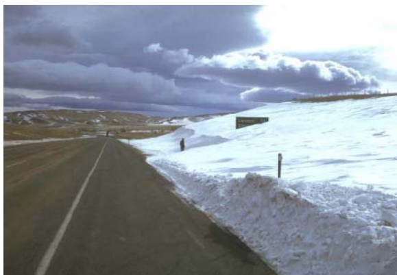
図 2.7 防雪柵設置前のワイオミング I-80, 280.8 マイル地点の積雪状況(左)と,防雪柵設置後 31 年間の続いた積雪状況(右上).この地点の空中写真(Tabler 1973a)
