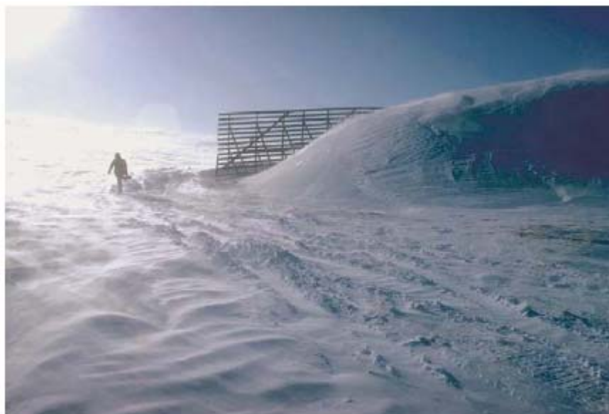
図 3.42 吹きだまり 端部では円弧状に堆雪するため、この柵高 3.8m のワイオミングタイプの柵が示すように、防雪容量と捕捉率が減少する (Tabler 1986)
