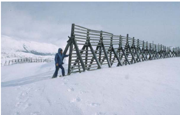
図 2.5 1900 年に建設された高さ 4 m の,Alaska, Skagway の北およそ 25km に位置す る,White pass と Yukon 鉄道の防雪柵。
