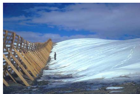
図 2.9 ワイオミング I-80, 269.5 マイル地点の防雪柵設置前（左上）, 及び設置後 31 年続いた典型的な積雪状況との比較（右）. 下の写真は同じ日、別な場所での防雪柵にできた吹きだまり, (Tabler 1973a から引用).
