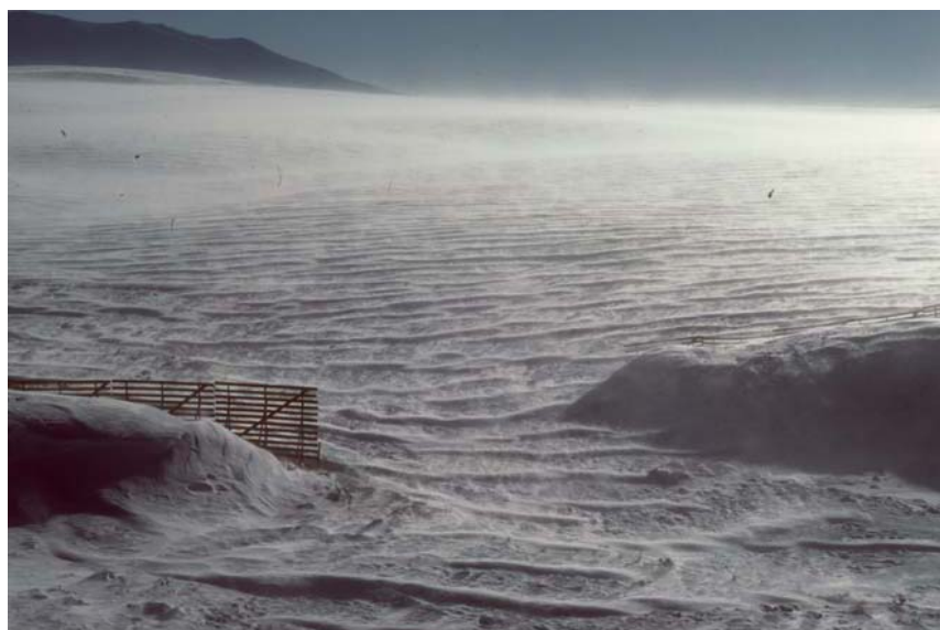
図 3.19 波模様（向かい 風）防雪柵の高さ 3.8m (Tabler 1986)
