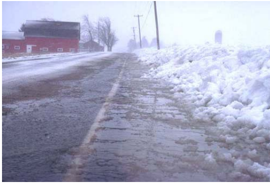
図 2.2 吹きだまりは排水を詰まらせ、舗装の下に水を浸透させることにより、道路を破壊する(左の写真は Tabler 1994 提供)
