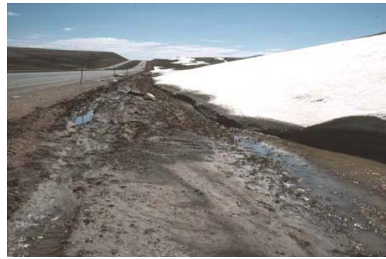
図 2.2 吹きだまりは排水を詰まらせ、舗装の下に水を浸透させることにより、道路を破壊する(左の写真は Tabler 1994 提供)
