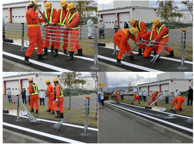
緊急時の開放区間設置試験（支柱の取り外し）
