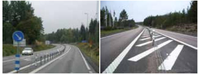
スウェーデンのワイヤーロープ式防護柵付きの2 + 1車線道路
