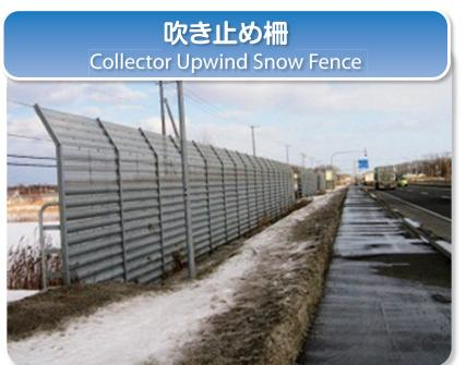
(機能/Function) 吹き払い柵 Blower Snow Fence 角度を設けた防雪板 Angled snowbreak slats Bottom gap 加速されて吹き抜ける強い風 Wind that accelerates as it passes through the slats 道路
