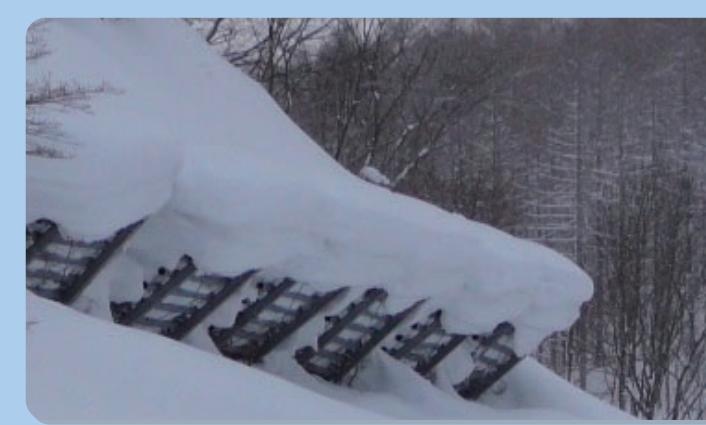
▲巻きだれの発達事例 Snow eaves on avalanche fences
