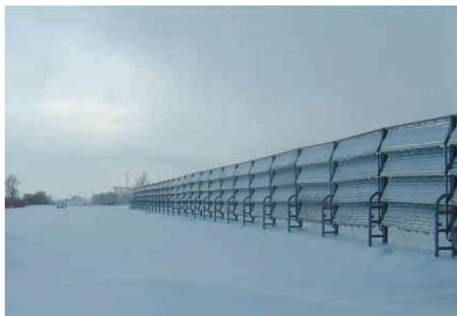
高機能吹き払い柵の試験状況
