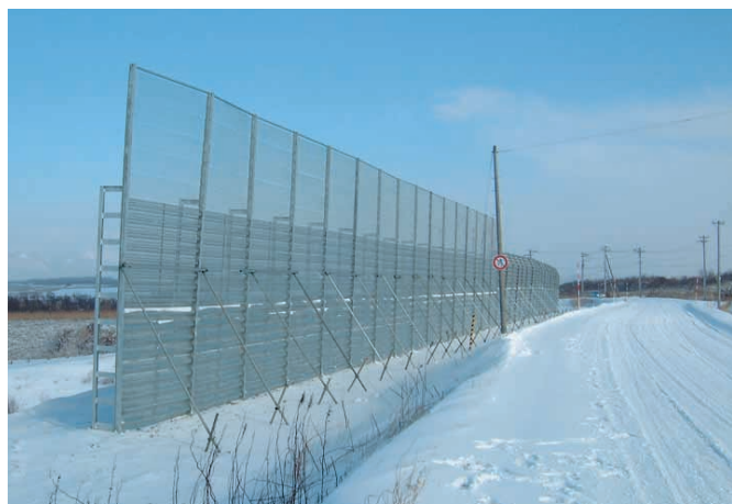
高機能吹き止め柵の試験状況
