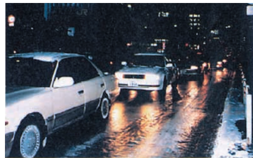
つるつる路面発生状況
