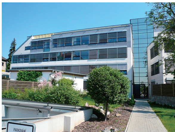
写真-9 RMD 本部の外観
