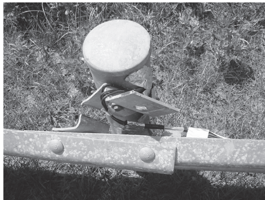
写真－7 雪圧測定した支柱(脱落後)
