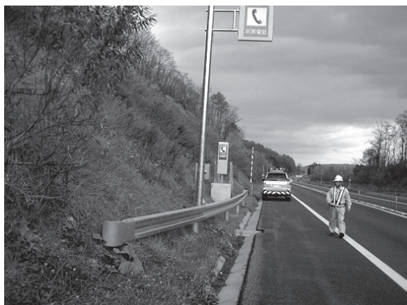
写真-1 切土部に設置されているガードレール
