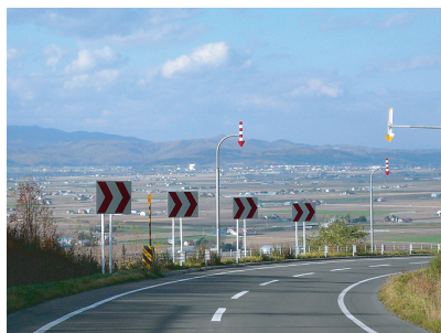
写真-4 標識によって、眺望が遮られているが、冬期のスリップなどの危険のためカーブに設置されている例も少なくない
