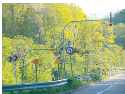
写真-5 ガードケーブル末端での付属物の連鎖が起き、かえって分かりづらくなっている事例
