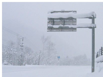
写真-6 片持ち式案内標識への着雪事例
