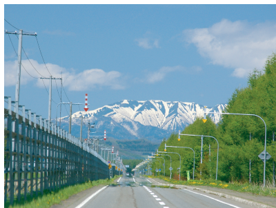
写真-3 電線や防雪施設は必要な施設であるが、これによって視界の広がりが見え隠れしている
