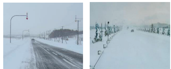
(固定式視線誘導柱) (視線誘導樹)
