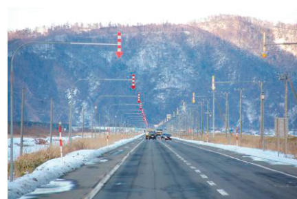
写真－2 矢羽根の設置状況
