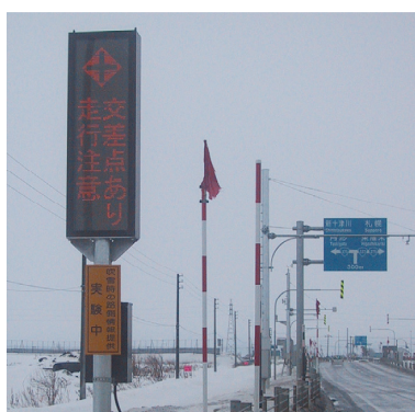
図7 実験機器の設置状況(左：自発光視線誘導標、中：路側情報板、右：道路センサ(ミリ波センサ))
