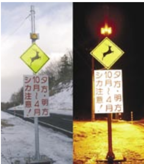
写真-2 エゾシカ注意標識の設置状況
