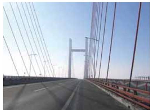
写真-13 四方台大橋（斜張橋）
