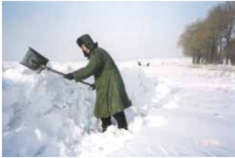
写真-10 雪堤を築く作業員
