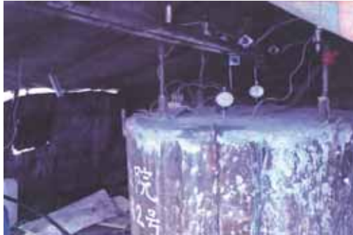
写真－3 橋梁基礎静載荷試験
