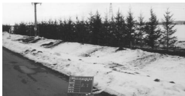
写真－1 狭帯防雪林（2条）の設置状況 （手前に3条林、奥に1条林がある）
