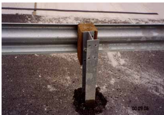
写真7 ガードレール
