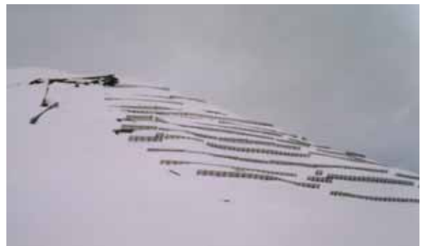
写真8 ワイスフルーの頂上付近の雪崩予防柵
