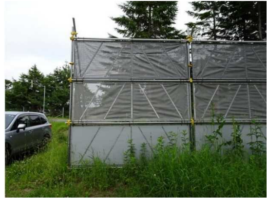
図-151 茶内防雪林で施工されているネット柵工
