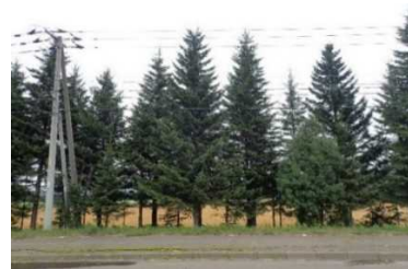
図-17 水上防雪林の外観
