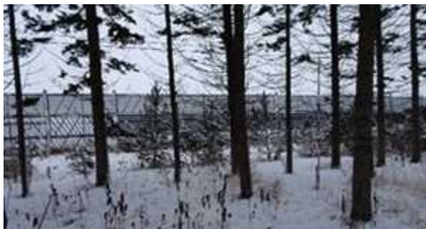
図-160 風上側林縁の防風ネット柵 (KP66.470～66.590)
