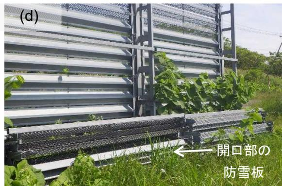
写真4.4.4 脱着式基礎部を用いた開口部の例3（吹き止め柵）
