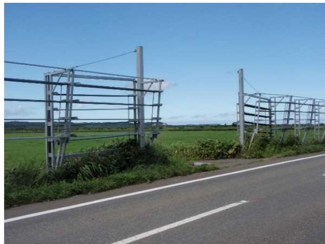
写真4.4.7 門扉式の開口部の例2 (吹き払い柵)<sup>1)</sup>
