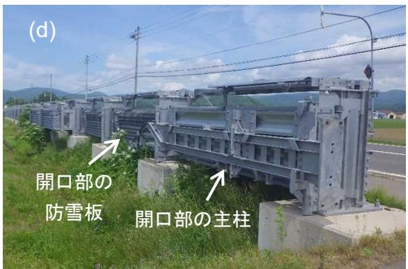
写真4.4.3 脱着式基礎部を用いた開口部の例2（吹き止め柵）
