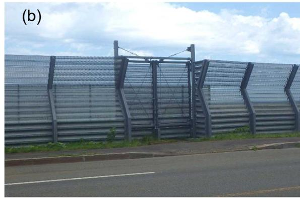
写真4.4.6 門扉式の開口部の例1 (吹き止め柵)
