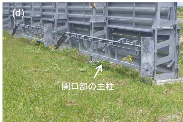
写真4.4.2 脱着式基礎部を用いた開口部の例1（吹き止め柵）
