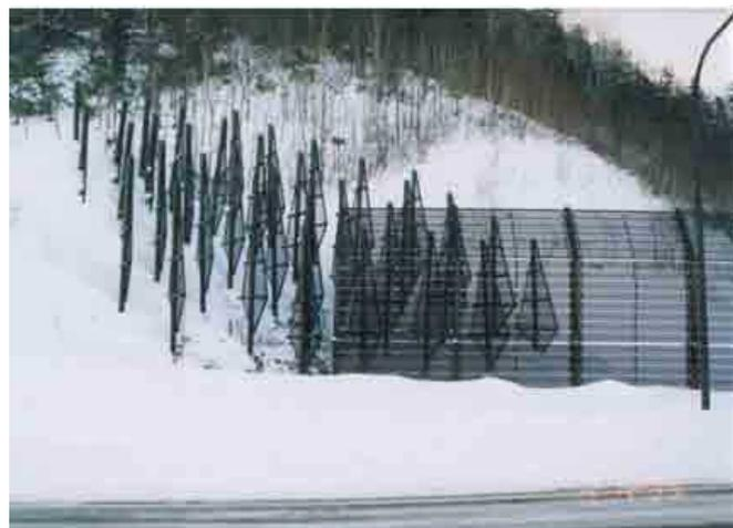
写真4.4.9 端部対策施設として擬木板を配置した事例<sup>1)</sup>
