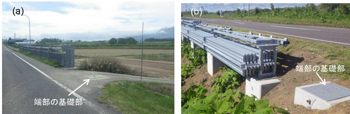
写真4.4.8 脱着式基礎部を用いた防雪柵端部の例
