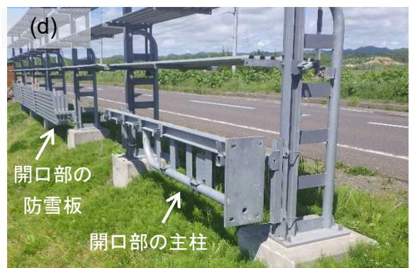
写真4.4.5 脱着式基礎部を用いた開口部の例4（吹き払い柵）
