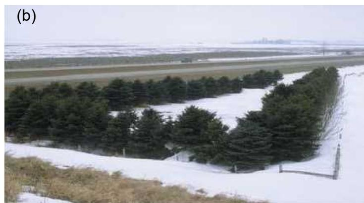
図4.4.1 ミネソタ・スノートラップ (Minnesota snow trap)<sup>55)</sup>
