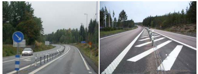
スウェーデンのワイヤーロープ式防護柵付きの2+1車線道路
