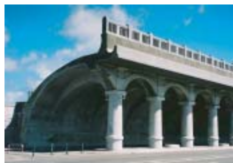
稚内港北防波堤ドーム
