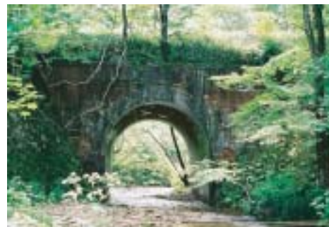
狩勝峠鉄道施設群－小笹川橋梁
