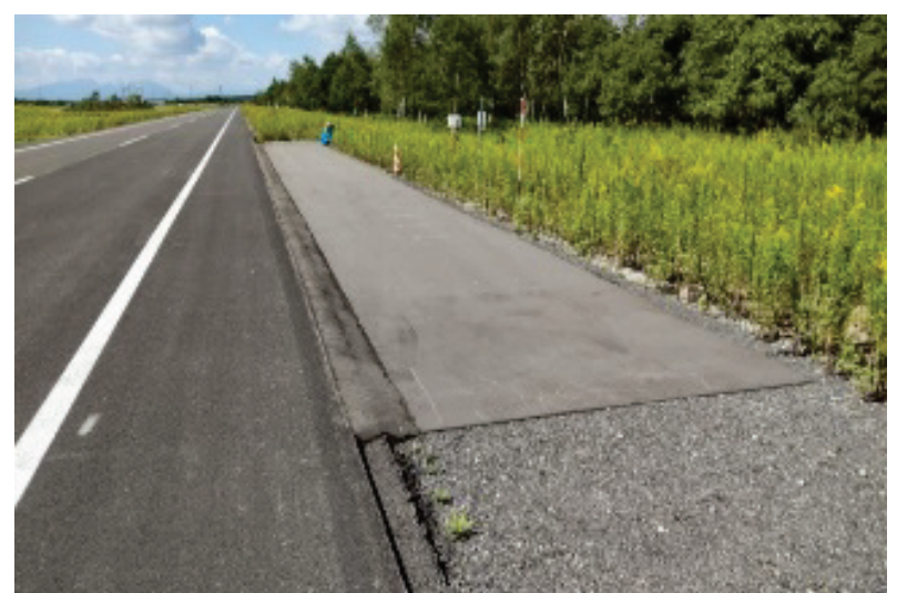
⑩歩道舗装試験路
