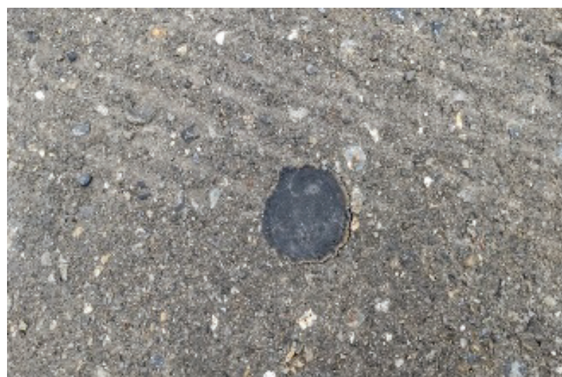
⑦磁気マーカー (自動運行補助施設)
