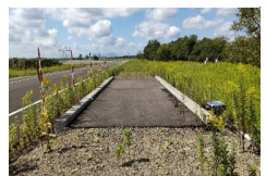
⑬橋面舗装試験路
