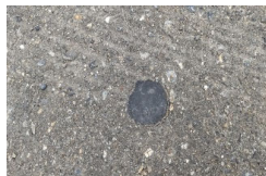
⑧自動運転試験 (磁気マーカー設置)
