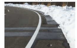
⑮路肩舗装表面切削 ・研削溝
