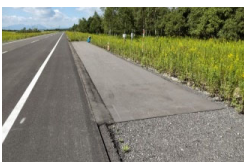
⑪歩道舗装試験路
