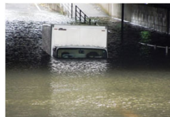
アンダーパスの排水処理不足による路面冠水
