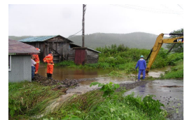
大雨による沢地形からの出水、排水工清掃忘れ及び排水処理不足
