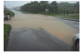
大雨による沢地形からの出水、排水処理不足
