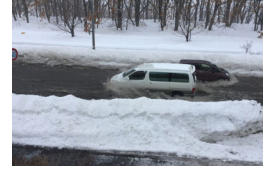
融雪時期による路面冠水路肩堆雪で排水樹が閉塞
