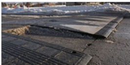
▲ 除雪作業中にハンプ傾斜部がプラウで損傷した事例 (カナダ・オンタリオ州ハミルトン)
