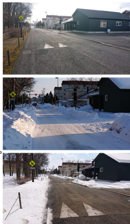
▲ ハンプを存置して除排雪をしている事例 (北海道帯広市)
