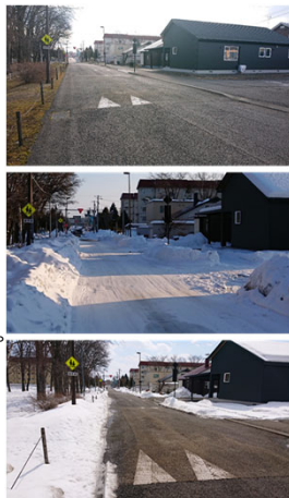
▲ ハンプを存置して除排雪をしているケース (北海道帯広市)
