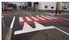
▲ スムーズ横断歩道を試験設置した事例 (北海道札幌市)
