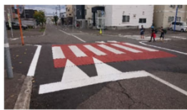
▲ ハンプを存置して除排雪をしているケース (北海道帯広市)
