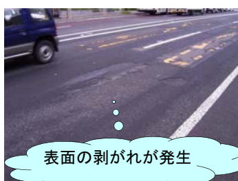
排水性舗装の破損状況
