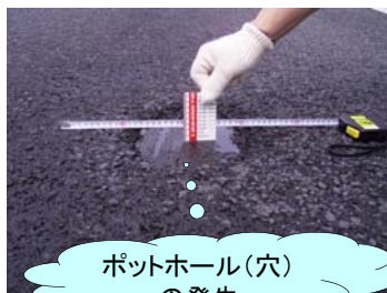
排水性舗装の破損状況
