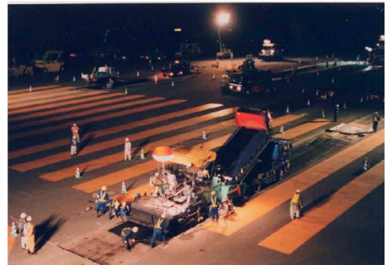
写真-4 大粒径中温化アスコンの施工状況
