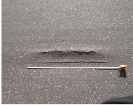
写真-1 滑走路に発生したプリスタリング現象
