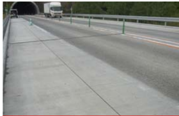
コンクリート舗装(新設)
