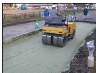
ガラスカレットの施工状況
