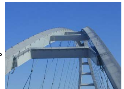
格子フェンス工法 設置状況
