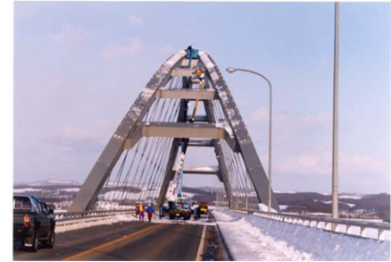
高所での雪下ろし作業
