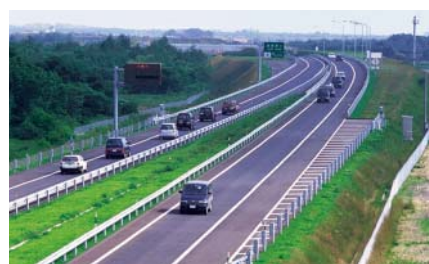
日高自動車道 厚真インターチェンジ付近
