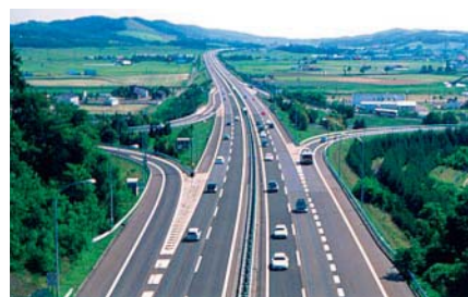
道央自動車道 三笠インターチェンジ
