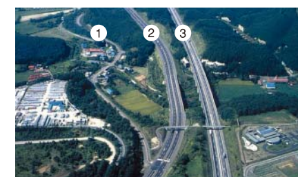
一般国道36号 島松沢バイパス 1.北広島市道島松駅通線(旧国道36号) 2.現在の国道36号 3.道央自動車道(高速道路)
