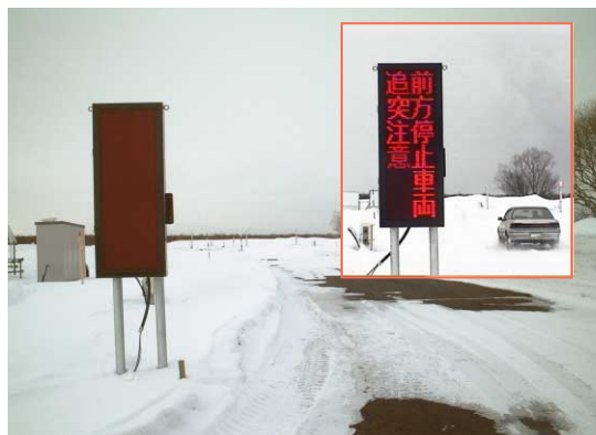
カーブ区間手前に設置した路側情報板
