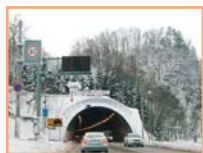
一般国道12号 神居古潭トンネル (旭川市)
