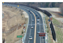
旭川紋別自動車道 白滝丸瀬布道路（白滝町）
