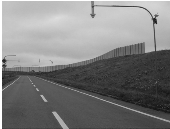
写真4-2-2 防雪切土における防雪柵設置例
