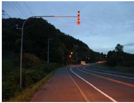
写真4-3-8 自発光式の固定式視線誘導柱（矢羽根）の設置例
