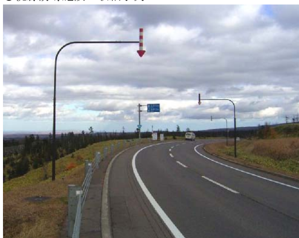
写真4-3-9 景観に配慮し固定式視線誘導柱を収納式とした事例
