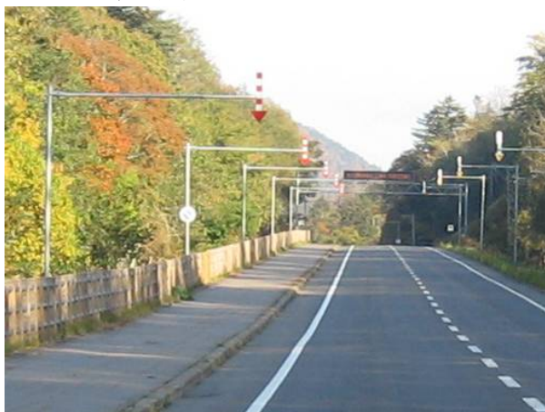
写真4-3-10 標準的な固定式視線誘導柱と支柱の色彩と植樹による修景を行った固定式視線誘導柱の設置例 (一般国道240号 阿寒湖畔)
