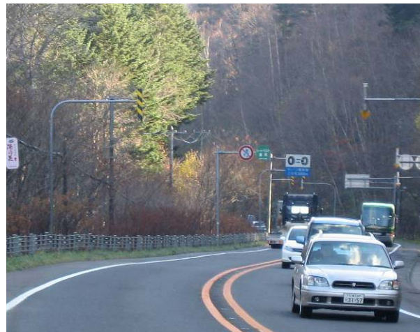
写真4-3-8 固定式視線誘導柱の標準的な矢羽根と道路景観に配慮した矢羽根の設置例
