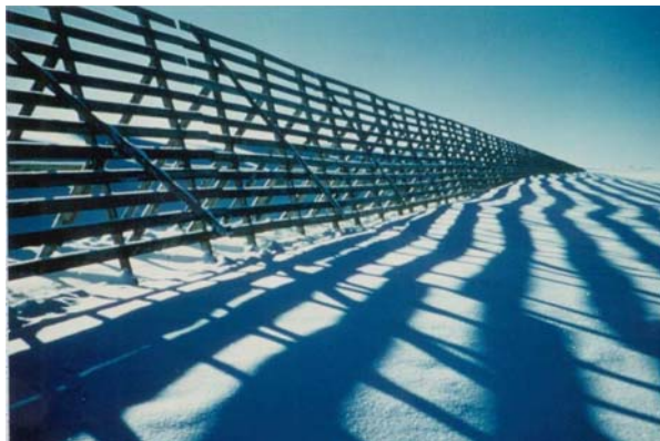
写真3-3-2 景觀に配慮した木製防雪柵の設置例
