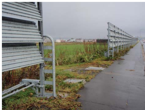
写真3-3-8 脱着式基礎部（吹き払い柵）
