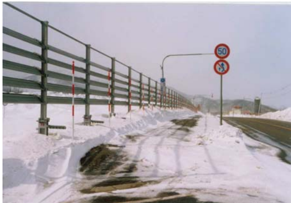
写真3-3-1 ドライバーの側方視界や景觀に配慮し、夏期に収納できる防雪柵の設置例
