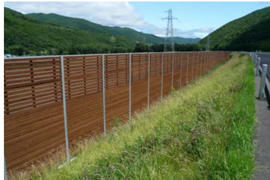
写真3-3-4 木製防雪柵設置事例（高規格道路）
