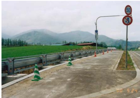
写真3-3-1 ドライバーの側方視界や景觀に配慮し、夏期に収納できる防雪柵の設置例
