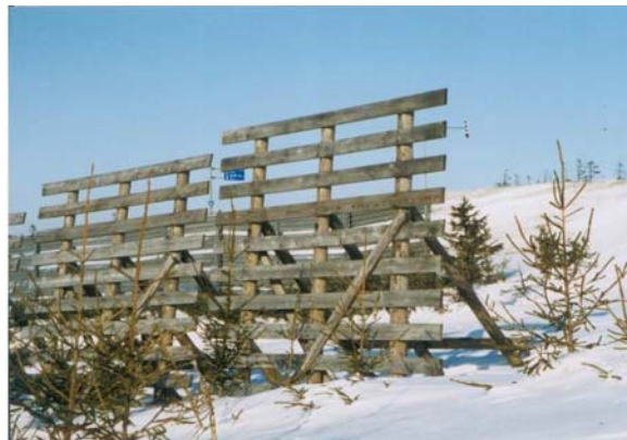
写真3-3-2 景觀に配慮した木製防雪柵の設置例
