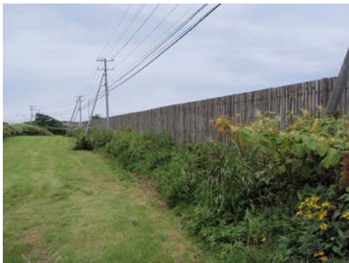
写真3-3-3 木製防雪柵設置事例（一般道路）
