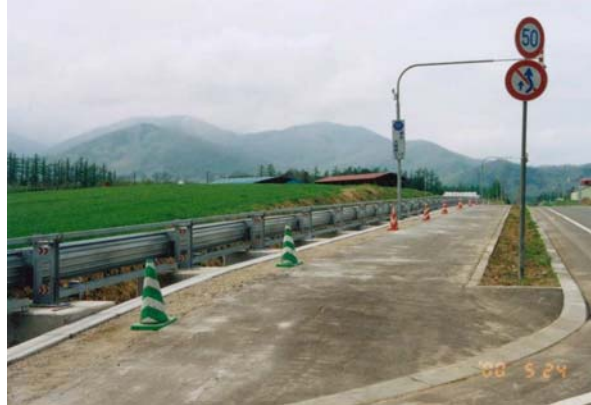
写真3-3-1 ドライバーの側方視界や景観に配慮し、夏期に収納できる防雪柵の設置例
