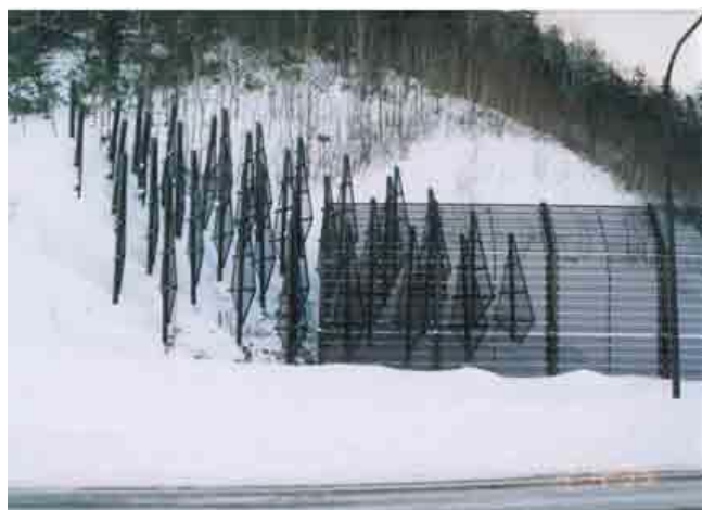
写真3-3-6 端部処理施設として擬木板を配置した事例（一般国道273号）
