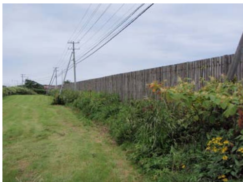
写真3-3-3 木製防雪柵設置事例（一般道路）
