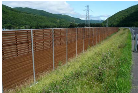
写真3-3-4 木製防雪柵設置事例（高規格道路）
