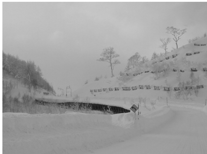
写真3-2-3 吹き上げ防止柵
