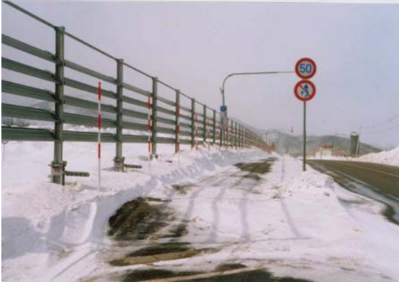
写真3-3-1 ドライバーの側方視界や景観に配慮し、夏期に収納できる防雪柵の設置例
