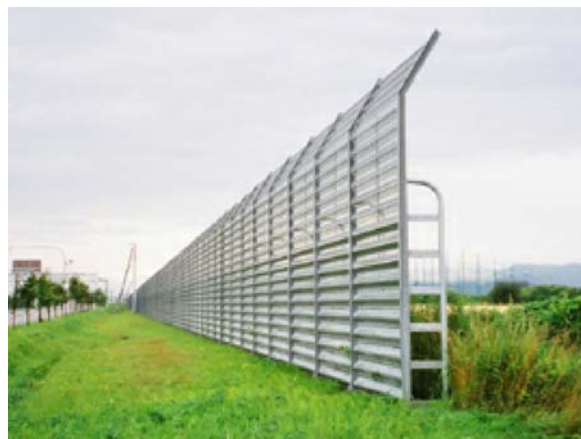
写真3-6-1 防雪柵の連続性
