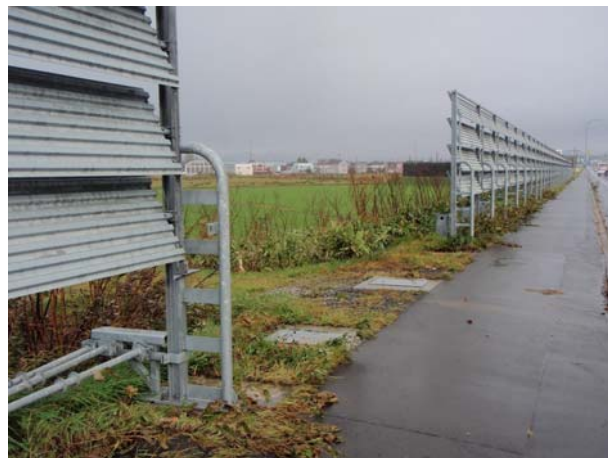
写真3-3-8 脱着式基礎部（吹き払い柵）
