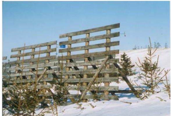
写真3-3-2 景観に配慮した木製防雪柵の設置例
