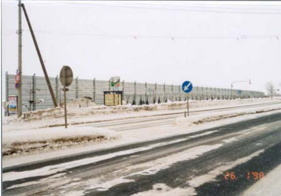
▼吹き止め柵（設置時）
