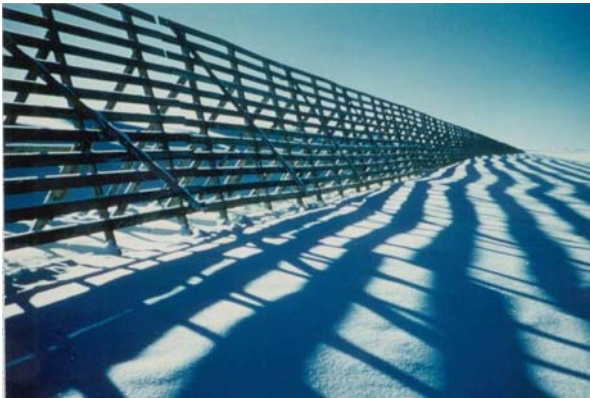
写真3-3-2 景観に配慮した木製防雪柵の設置例
