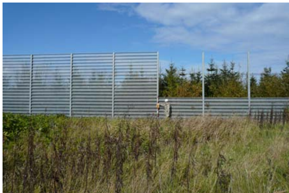
写真2-4-2 下部を残した防雪板の撤去事例
