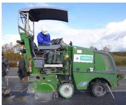
写真6-3. 大型車対応ランブルストリップス施工時の状況
