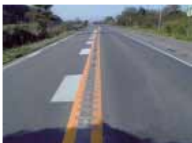
写真 5-5. 滑り止め区画線を併用した施工例（R5）①
