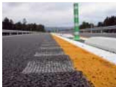
写真 5-2. 暫定2車線区間の中央帯における施工例（常磐道）
