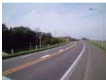
写真 5-6. 滑り止め区画線を併用した施工例（R5）②
