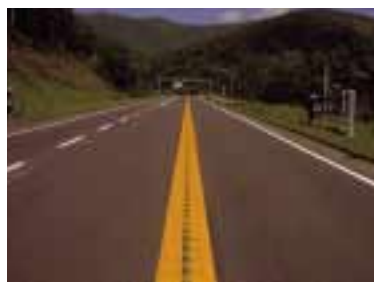
写真 5-4. 登坂車線における施工例（R274）
