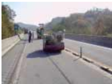
写真 5-1. 暫定2車線区間の中央帯・路肩における施工例（浜田道）
