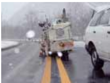
写真 4-7. 上下車線に段差があり施工が困難な状況
