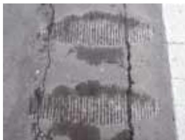
写真 4-10. 段差がある場合の施工例②
