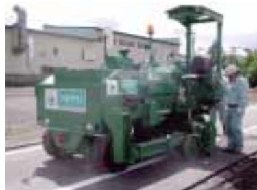
写真3-3. ランブルストリップス施工専用機 (路肩設置専用機)
